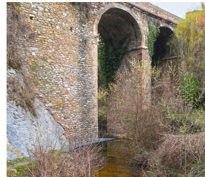
Pasarela para dar paso al "Camí de l'Aigua" y vista de los arcos de medio punto en su estado actual.
